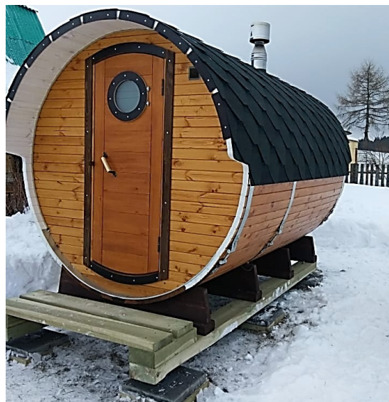
Фундамент на регулируемых опорах.
