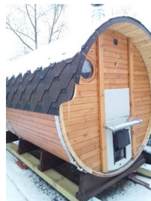
Фундамент на регулируемых опорах.
